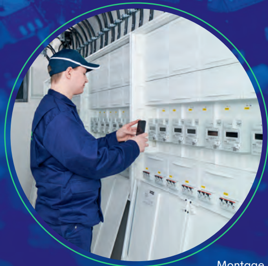
Montage der Smart Meter
